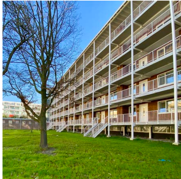
Figuur 18. De vernieuwde Wiltonflats
